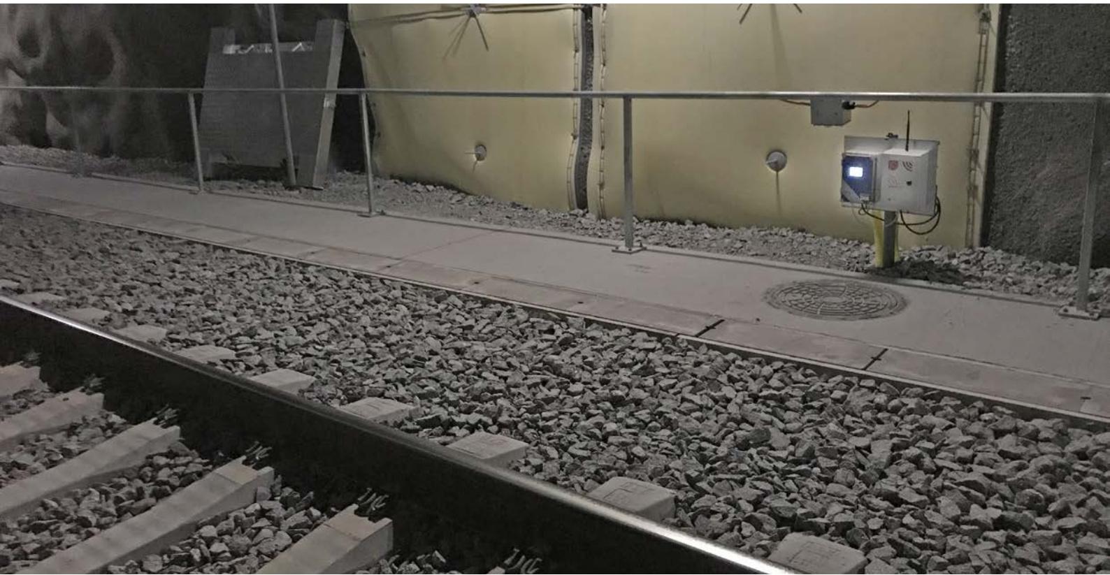
Bild från NCC Infrastructure Strängnäs. AVFM 6.1 flödesmätare för öppna system och Paab GSM
